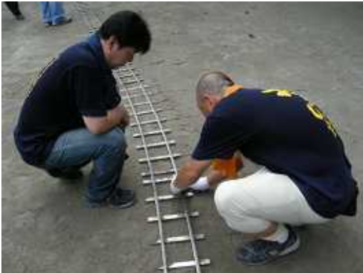
線路敷設工事
